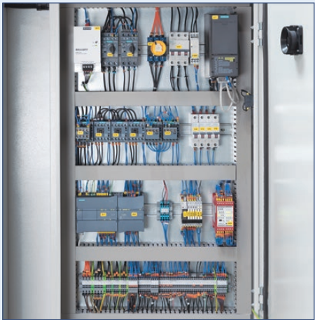
Klare Struktur: Eine übersichtliche Anordnung der Komponenten erleichtert die Wartung und Fehlersuche
